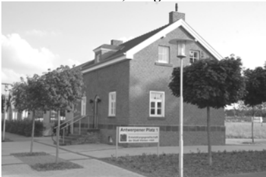
Brückenwärterhaus Nordkanal VIERSEN, Antwerpener Platz 1
